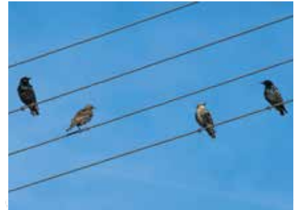
Abb.: Beispiel: Spannungseinbrüche durch Vogelkot
